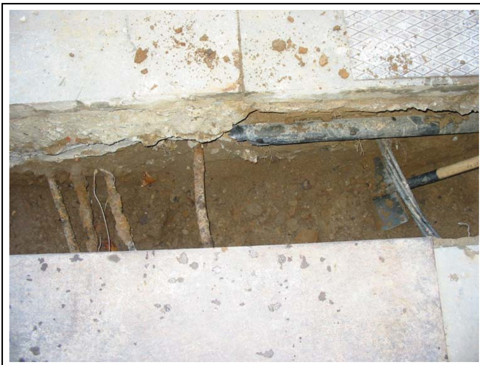
Fotografia 6. Vista dels serveis existents.
