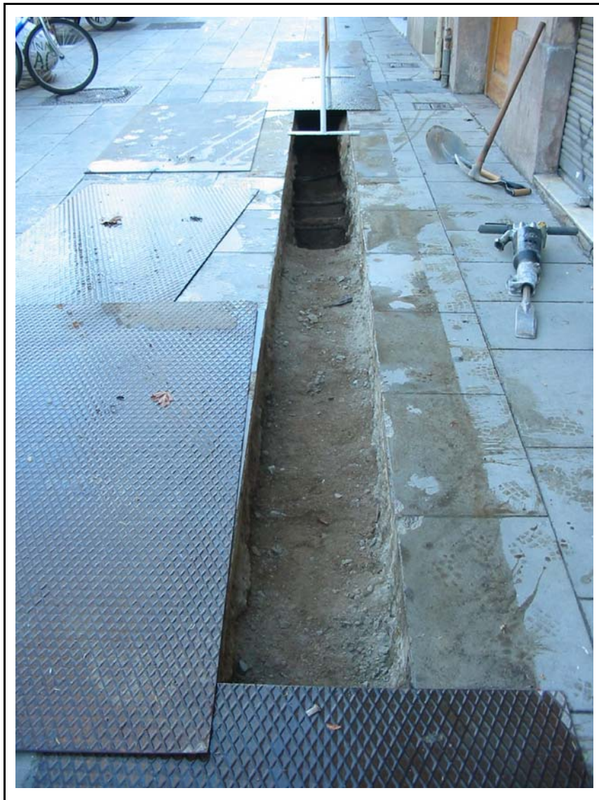
Fotografia 3. Vista d'un tram de la rasa on s'ha extret el paviment mitjançant martell pneumàtic.
