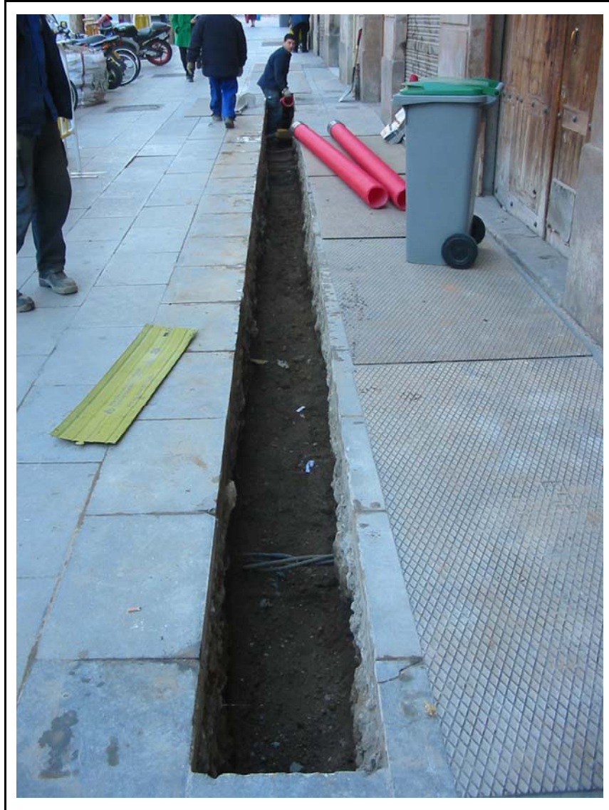
Fotografia 5. Visió general de la rasa un cop excavada.
